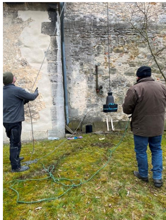
Bilder 15 und 16: Die Glocke wird mit Flies (Malte Meiners, Fachwerk Kontor) ummantelt und zur Turmöffnung hochgezogen.
