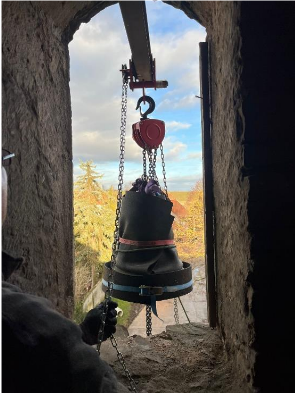
Bilder 3 und 4: Die Glocke wird mittels Kranbahn aus der Turmöffnung geführt und mit Hilfe von Kettenzügen herabgelassen.
